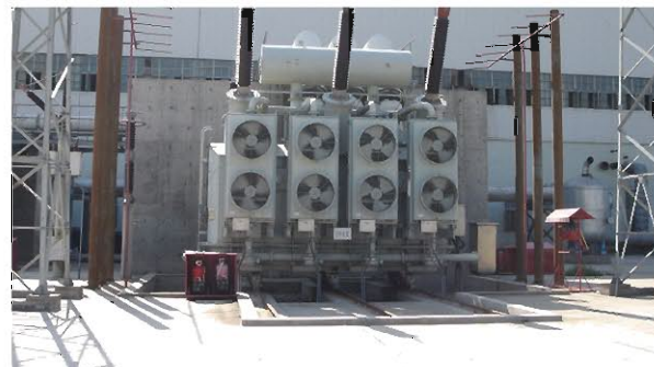
SFP10-200MVA/220kV
